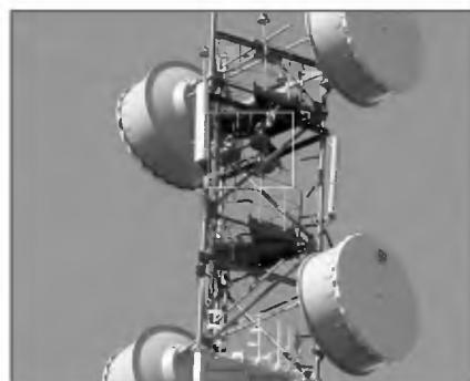
Это позволило снизить интенсивность колебаний в режиме ветрового резонанса в 3,6 раза, при воздействии пульсаций скорости ветра — в 2,7 раза, а также увеличить долговечность сооружения минимум в 6 раз.
